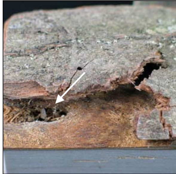
Abb. 4: Larvenfraß im Kambialbereich und ovales Einbohrloch der Larve in das Holz
