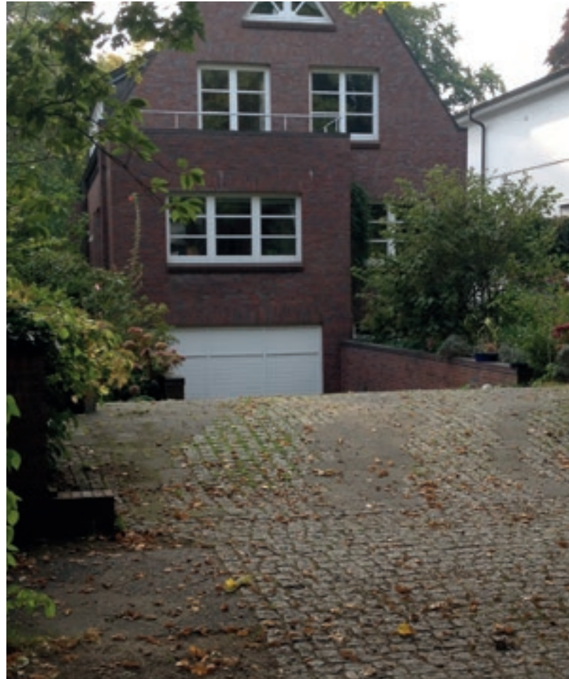
15 Garagenzufahrt mit Schutzschwelle
