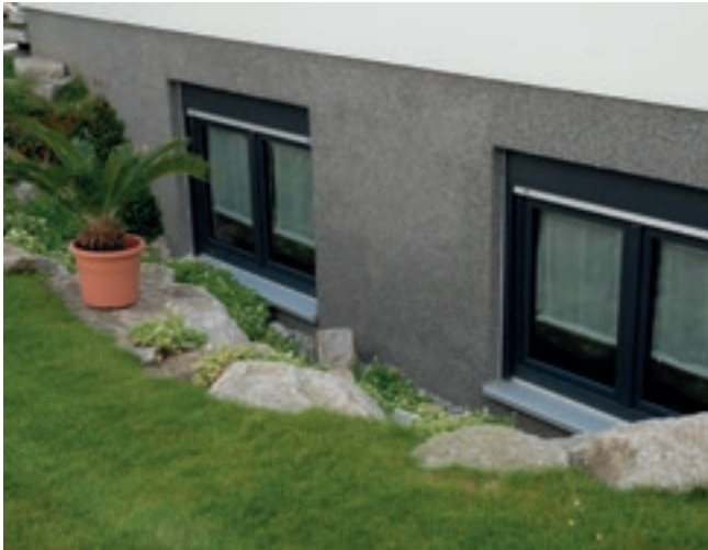
20 Kellerfenster mit Sockel
