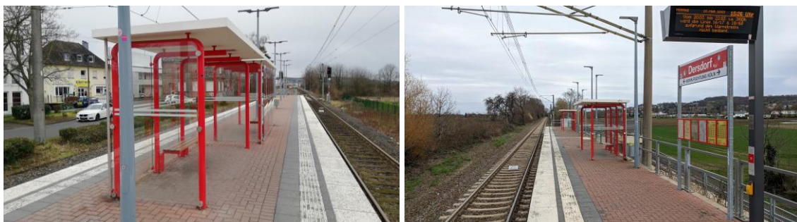
Abbildung 29: Barrierefreier Ausbau der Stadtbahnhaltestellen in Bornheim
