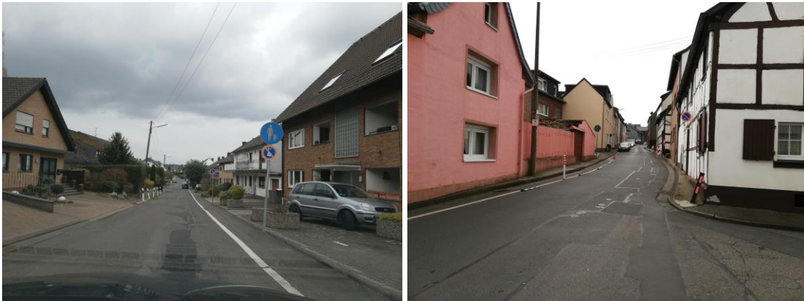
Abbildung 55: Unzureichende Gehwegbreiten in den Vorgebirgsorten
