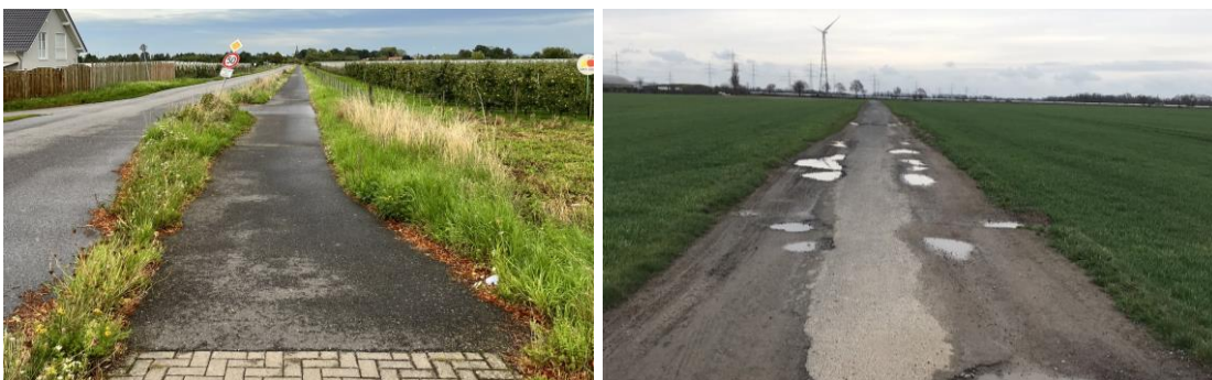
Abbildung 40: Radweg entlang der Händelstraße (links) und Wirtschaftsweg zwischen Sechtem und Widdig (rechts)
