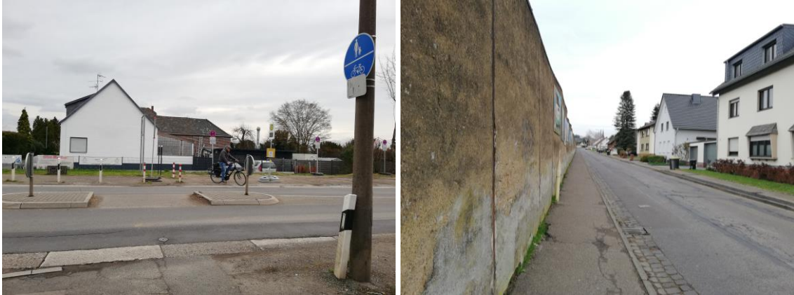
Abbildung 62: Nicht barrierefreie Querungsanlage an der Bonn-Brühler-Straße (links), schmaler Gehweg mit schlechtem Oberflächenbelag in Merten (rechts)
