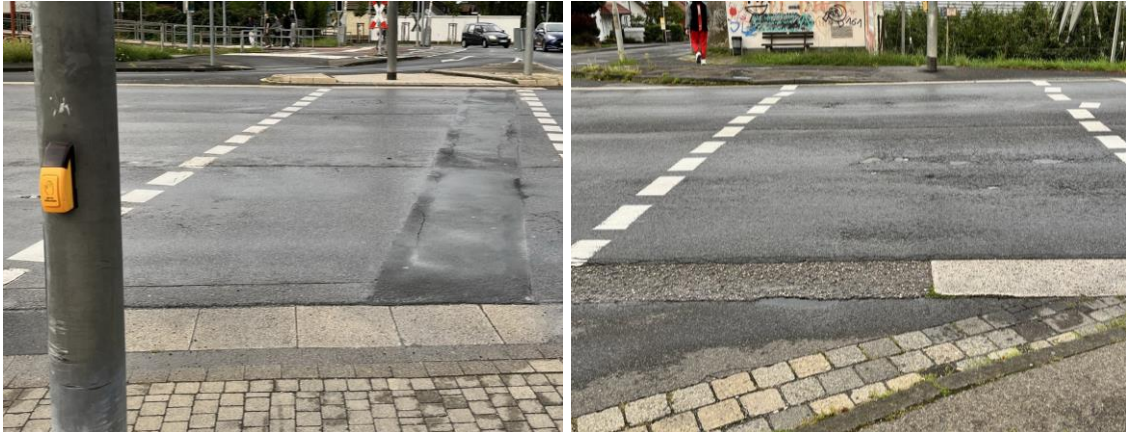
Abbildung 58: FGÜ entlang an der Kreuzung Walberberger Straße/Dominikanerstraße in Walberberg (links) und an der Bonn-Brühler-Straße in Merten (rechts)
