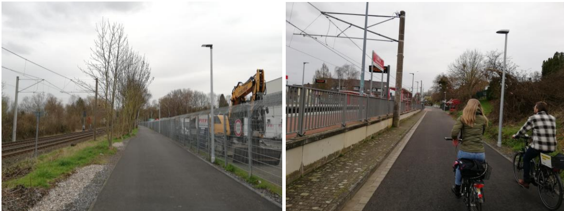
Abbildung 48: Fertiggestellter Abschnitt der RadPendlerRoute zwischen den Stadtbahnhaltestellen Bornheim Roisdorf West und Alfter / Alanus Hochschule
