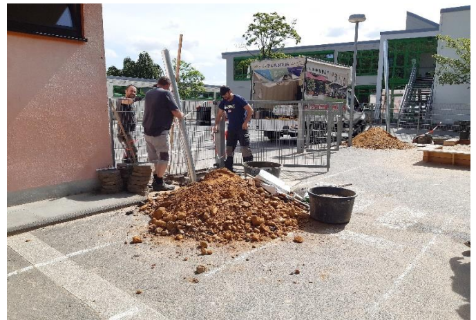
Arbeiter bereiten den Aufbau des Sonnensegels vor
