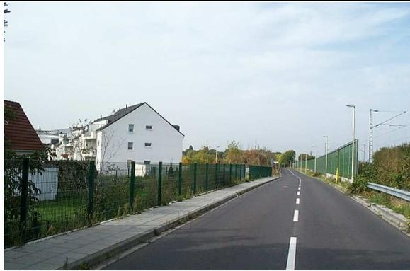
Das Foto zeigt auf der linken Seite die Neubebauung am Fußkreuzweg. Gut erkennbar sind die im Schallschatten des Gebäudes angeordneten Balkone (die örtlichen Verhältnisse mit Lage der Bahn im Nordosten ermöglichen diese Lösung). Die Lärmschutzwand an der Bahn dient der Kompensation der durch den Neubau der bahnparallelen Straße verringerten Höhe des Lärmschutzwalls an der Schule Europas.
