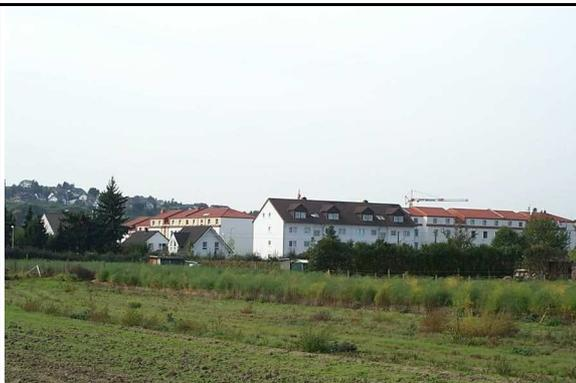
Am Fußkreuzweg ist in den letzten Jahren neue Wohnbebauung entstanden. Die Schallschutzprobleme wurden durch eine geeignete Grundrissgestaltung (schutzbedürftige Räume zur bahnabgewandten Seite hin orientiert) und ergänzend passiven Schallschutz (Schallschutzfenster) ohne aktive Maßnahmen (Lärmschutzwand) gelöst.
